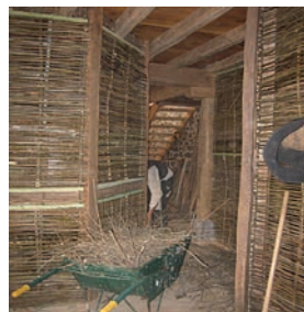
Tabiques. Este palé, tapado con cañizo, se puede rellenar de paja mojada en arcilla líquida y luego revocar.
