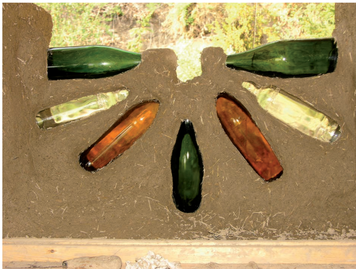
Muro de botellas y "cob".
