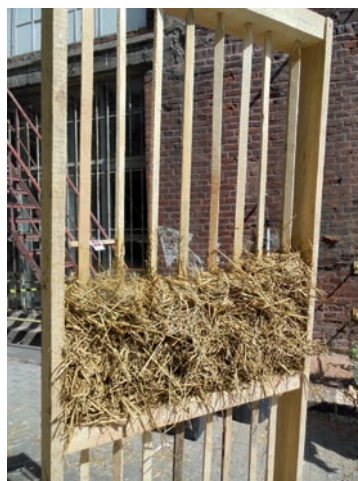
Tabiques. Este palé, tapado con cañizo, se puede rellenar de paja mojada en arcilla líquida y luego revocar.
