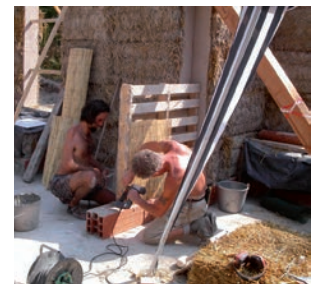
Tabiques. Este palé, tapado con cañizo, se puede rellenar de paja mojada en arcilla líquida y luego revocar.
