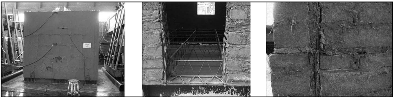
Figura 12. Aspecto del prototipo de adobe después del ensayo. Vista general, puerta y una esquina. Figure 12. Look of the adobe prototype after the test. General view, door and a corner.
